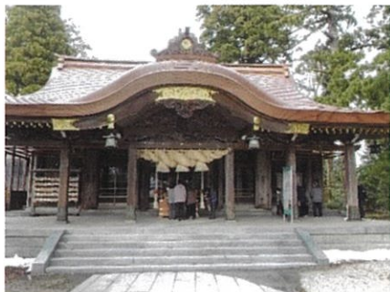
葺き替えられた御社殿銅板屋根
